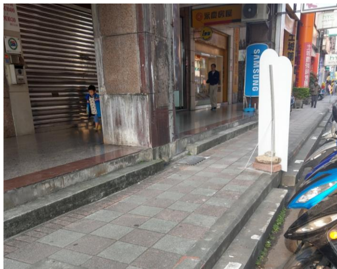
騎樓側與路側皆設台階(新北市)
