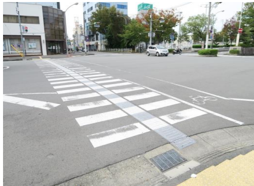
行穿線中央設置引導設施
