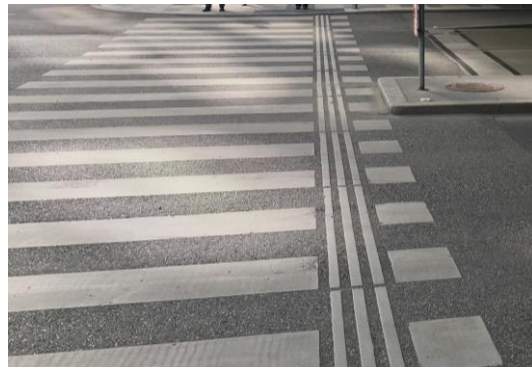
行穿線邊側設置引導設施 (奧地利)
