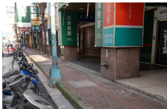
臨路側設置台階，騎樓與人行道順接(新北市)
