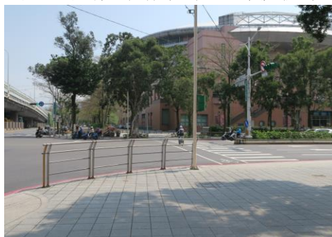
轉角設置護欄、欄杆
