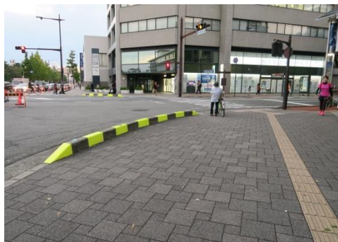
以緣石作為扇形路緣斜坡防護
