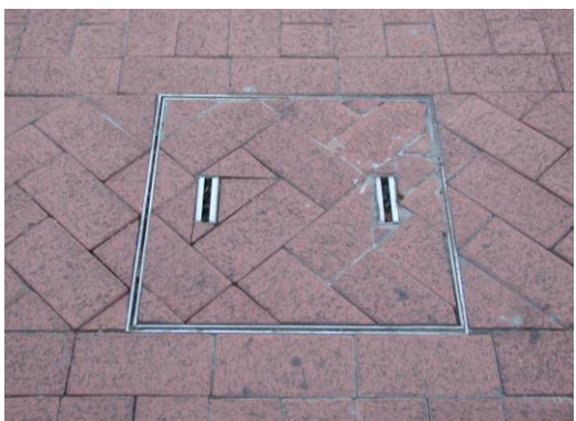
人手孔採化妝蓋板配合鋪面切磚(新竹)
