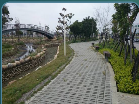
地點：桃園市風禾公園 說明：鋪面平整度、防護緣
