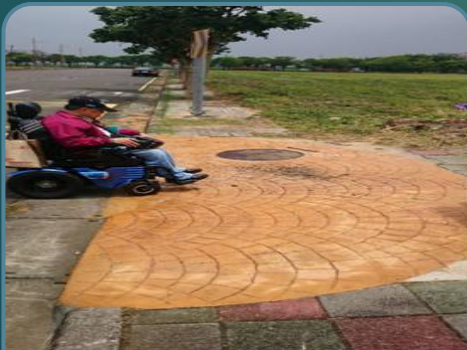
地點：嘉義縣公兒一 說明：斜坡坡度及防滑
