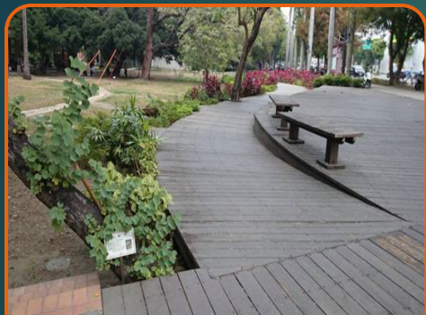
地點：台南市台南公園 說明：防護緣、護欄
