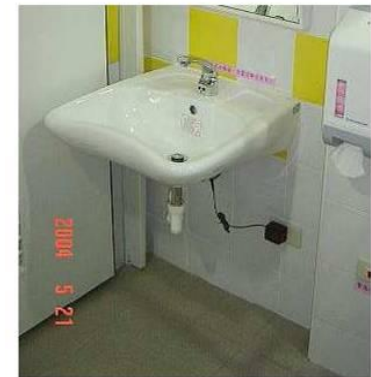
圖 3-46 供行動不便者使用廁所之便器側牆設備及洗面盆
